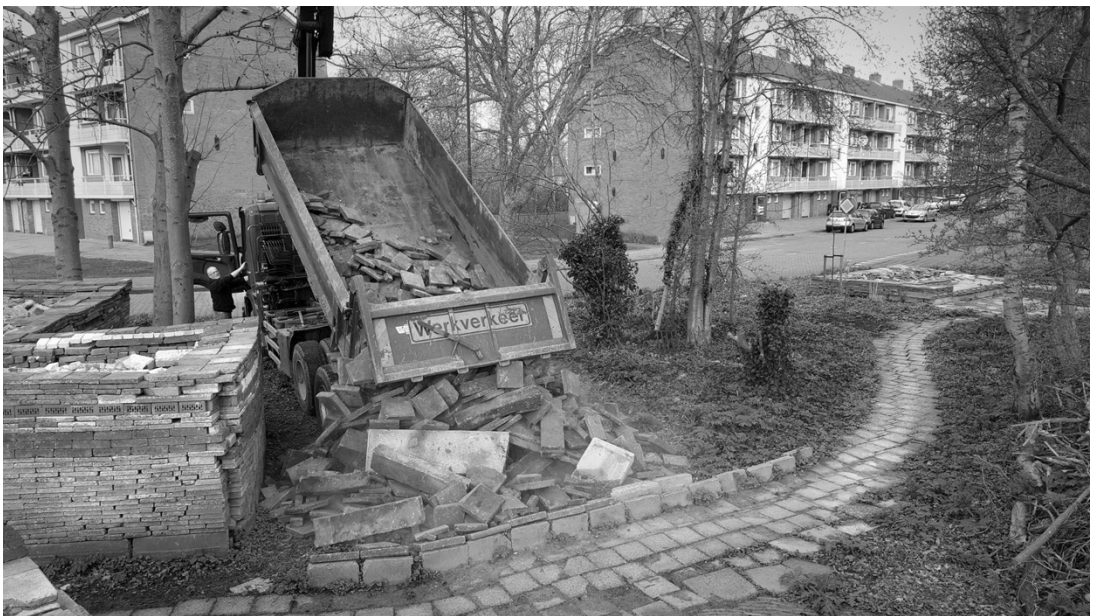
Boven: Kennedylaan Heerenveen kort na aanleg. Foto Louis Le Roy Onder: Nieuw stapelmateriaal wordt aangeleverd. Foto Peter Wouda
